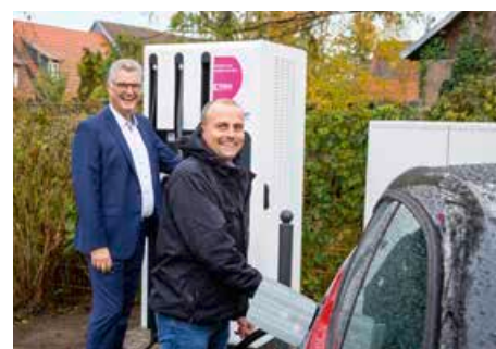
Volle Ladung: Stadtwerke-Geschäftsführer Detlef Koch und der Bereichsleiter Netzbetrieb Reiko Freier nehmen die neue Ladesäule in Betrieb.
